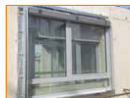
Cadre de pose sur béton
