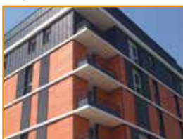
Façade en bardage
