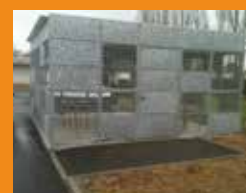
Abris à vélos
