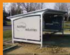
Abris à vélos
