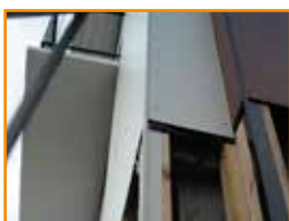
Façade en bardage
