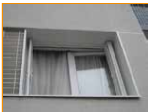
Linteau, appui, tableau sur ITE
